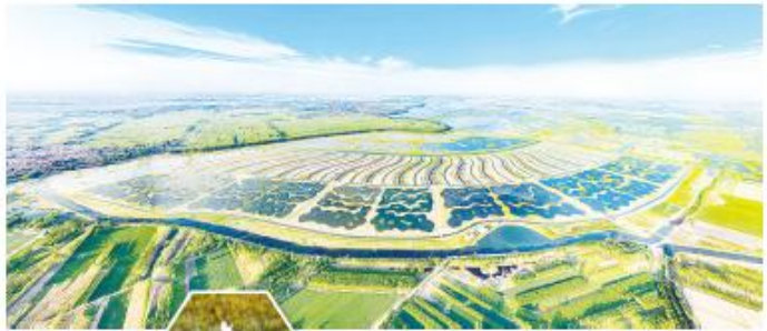
白洋淀生态修复工程实施后,白洋淀的自然生态功能得到了有效恢复,水环境质量得到了明显改善,生物多样性得到了有效保护。
